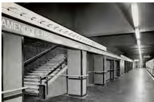
Banchina della stazione di Amendola-Fiera a lavori ultimati.
